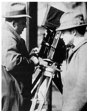
Oben: Karl Freund (l.) mit Assistent Robert Baberske und einer französischen 35mm-Kamera mit quer aufgesetzter Kassette (vermutlich Pathé Professional)
